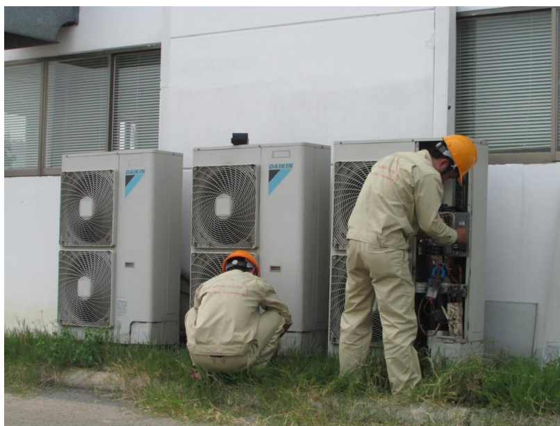
Hình 3: Kỹ thuật viên ngành công nghệ nhiệt đang bảo trì máy điều hòa không khí
