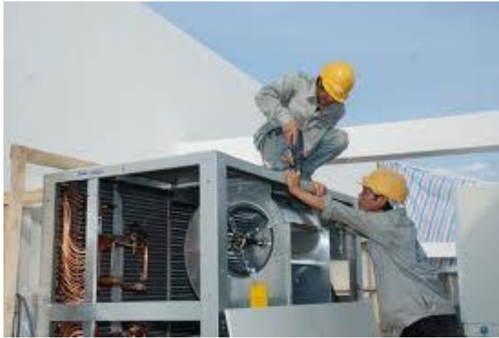
Hình 1: Kỹ thuật viên ngành công nghệ nhiệt đang thi công lắp máy
