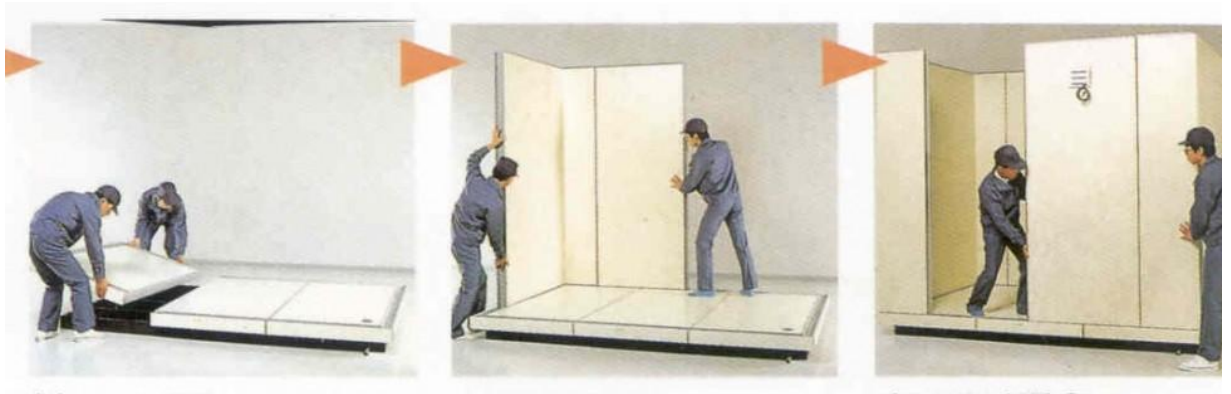
Hình 2: Kỹ thuật viên ngành công nghệ nhiệt lạnh đang lắp ghép kho lạnh
